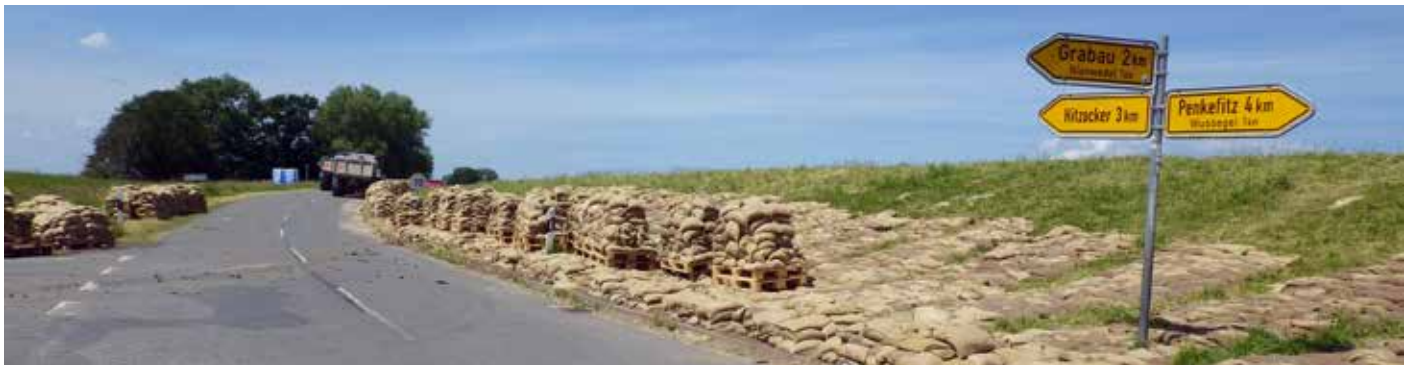
Sechs Millionen Sandsäcke wurden beim Elbe-Hochwasser 2013 eingesetzt – nun müssen sie wieder entsorgt werden.
