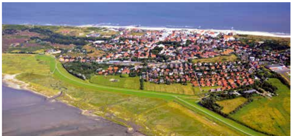
Ein Teil des drei Kilometer langen Dorf- und Ostgrodendeiches auf Wangerooge wurde 2014 erhöht und verstärkt – eine echte Herausforderung für den NLWKN.
