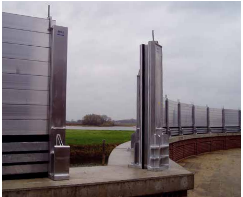
Mobile Hochwasserschutzwände wie hier in Hitzacker bleiben Niedersachsen die Ausnahme – aus Sicherheitsgründen.
