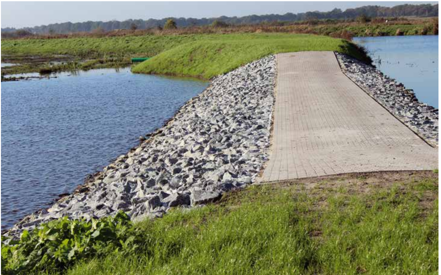
Abgeschlossen: Der Flutpolder Großfehn – hier die Überlaufschwelle zum Großfehnkanal – verbessert mit einer Fläche von 45.000 Quadratmetern den lokalen Hochwasserschutz erheblich.
