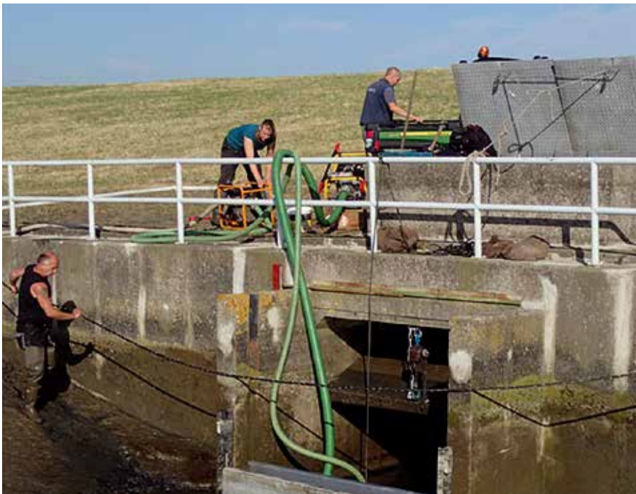
Zum Schutz der Inseln – funktionieren alle wasserwirtschaftlichen Anlagen? Hier die Bauwerksprüfung am Ostdeichsiel auf Langeoog.
