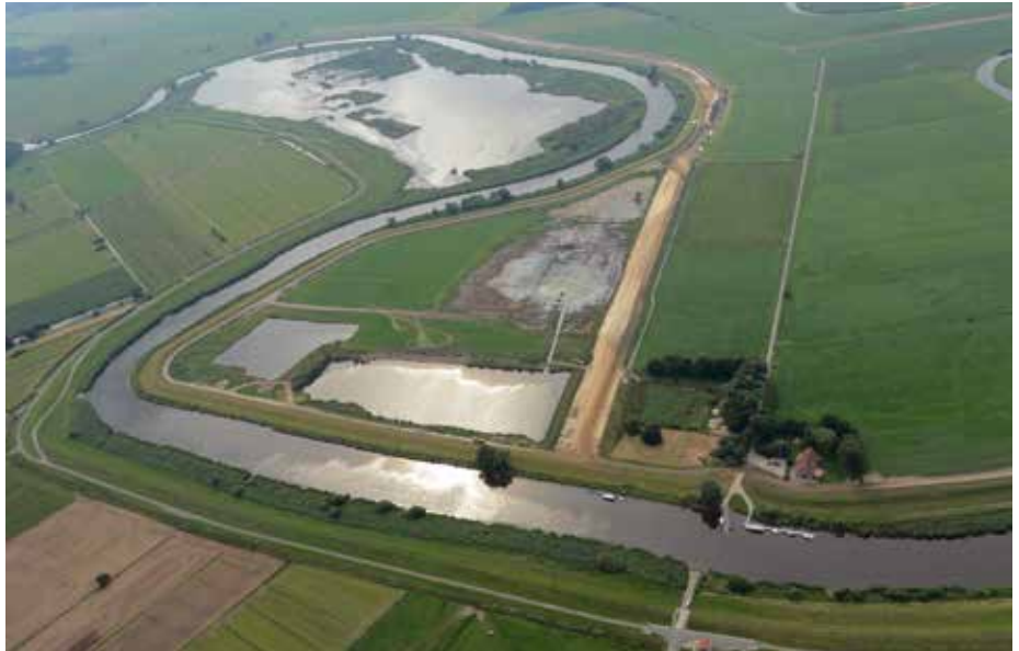
Viele wertvolle Biotope sind im Zuge der Rückdeichung an der Oste entstanden: Im hinteren Bildausschnitt die Rückverlegung und die Bodenentnahmestelle in Schönau im Deichverband Kehdingen-Oste; im Vordergrund die Deichverkürzung Hollander Höfen im Ostedeichverband.
