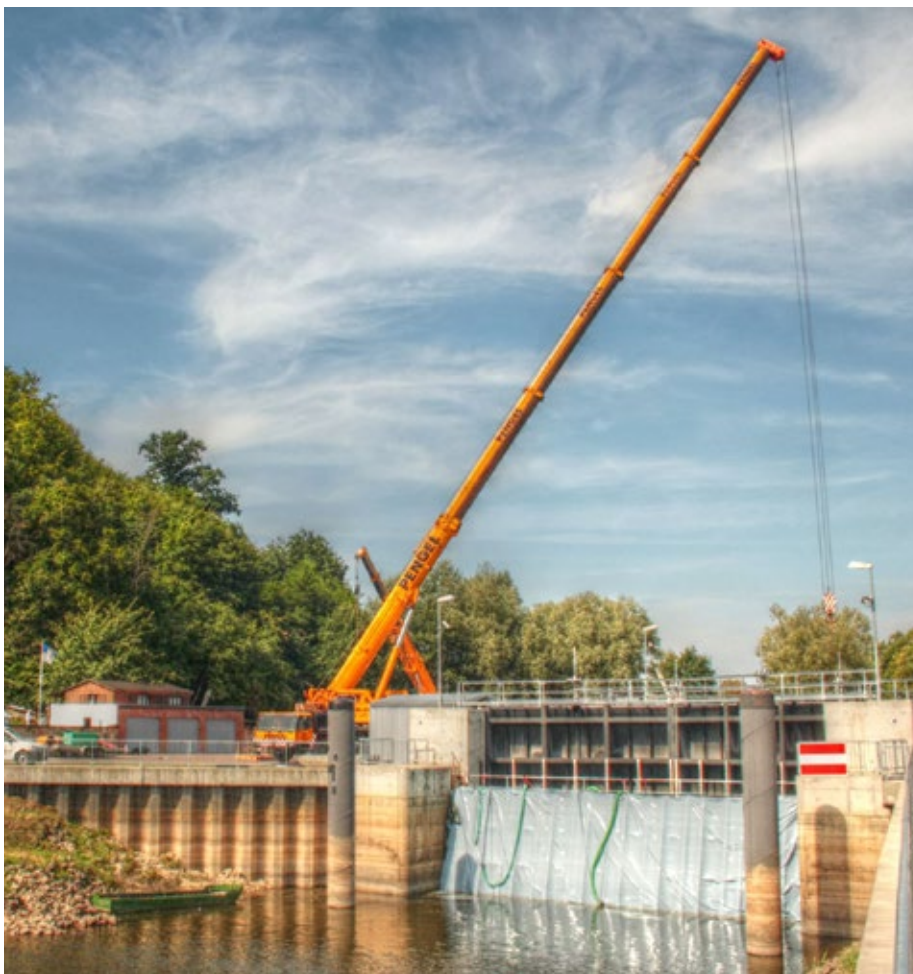
Die Mitarbeiter des NLWKN schauen bei der Bauwerksprüfung genau hin: Hier wird der trockengelegte Turbinenkanal im Schöpfwerk Hitzacker überprüft.
