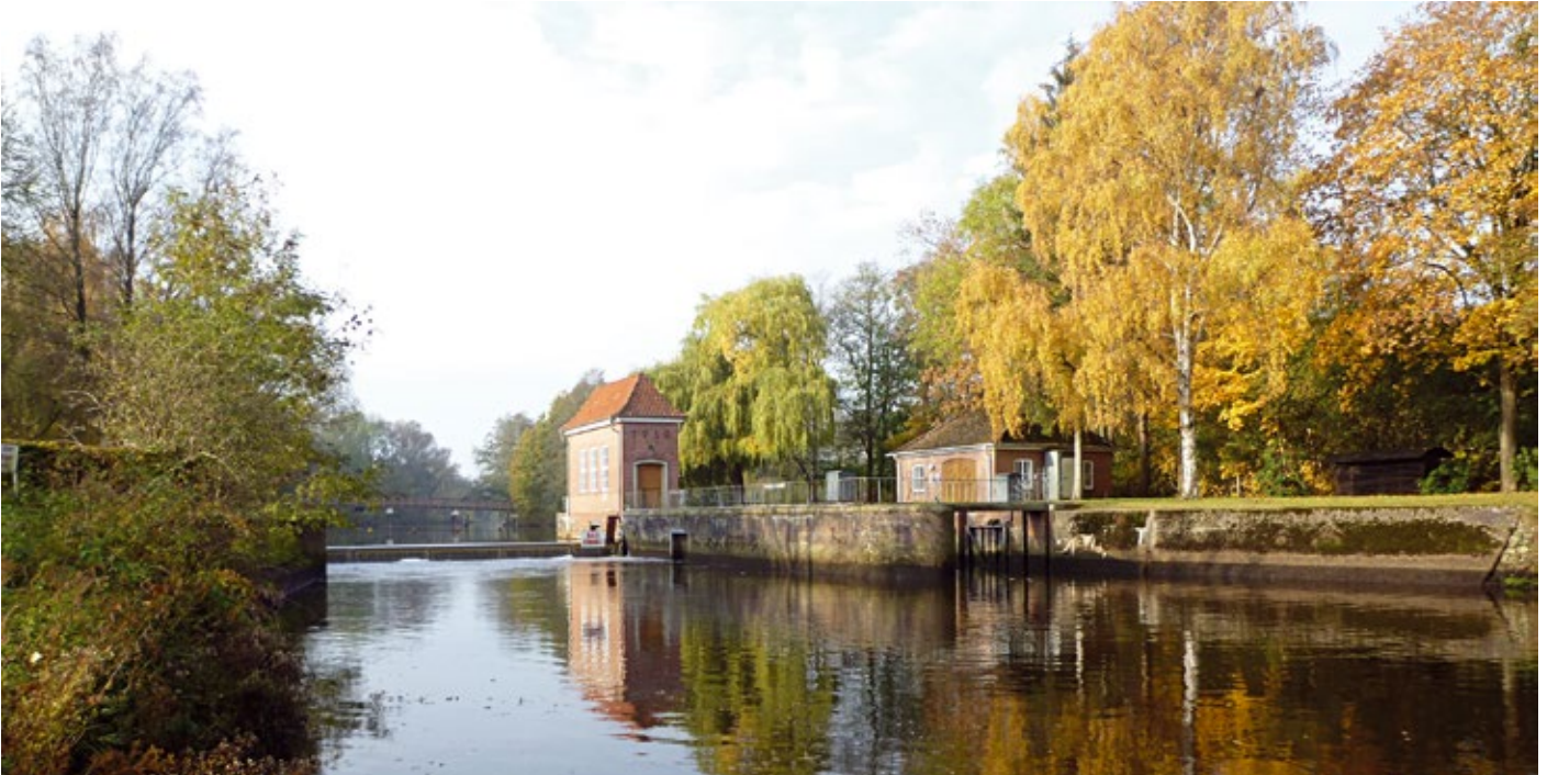
Wandern für Fische sehr schwer möglich: Das Wehr in Bremervörde ist derzeit noch das Hauptwanderungshindernis im Gewässersystem Oste. Der Umbau des Wehres wird derzeit vom NLWKN geplant.
