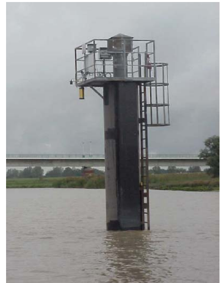
Ansicht Messstation Leerort
