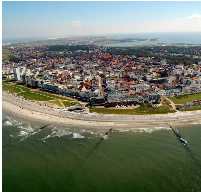
Durch Deckwerke und Bühnen gesicherter Westkopf von Norderney
