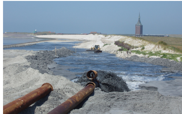
Kombinierte Strandauffüllung und Dünenverstärkung am Harlehorn auf Wangerooge
