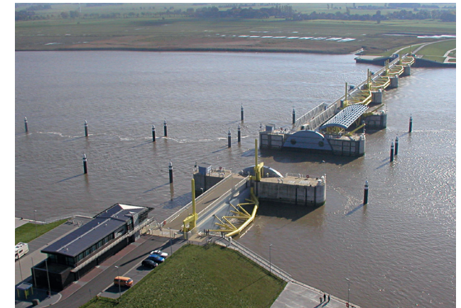
Emssperrwerk bei Gandersum
