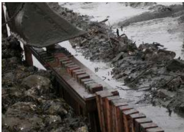
Lahnungsbau - wichtiges Element im Küstenschutz
