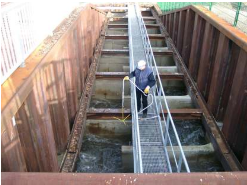
Blick in die Fischaufstiegsanlage Oldenburg
