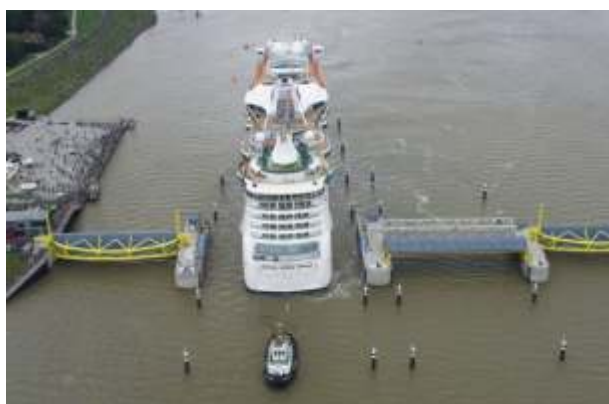
Präzisionsarbeit beim Emssperrwerk
