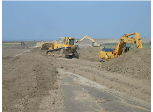
Deichbau in der Krummhörn
