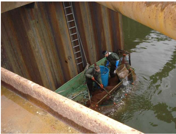
Fischfang in der Baugrube des Jeetzelsiels
