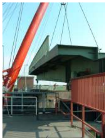
Die Klappbrücke im Sperrwerk Wischhafen wurde komplett erneuert
