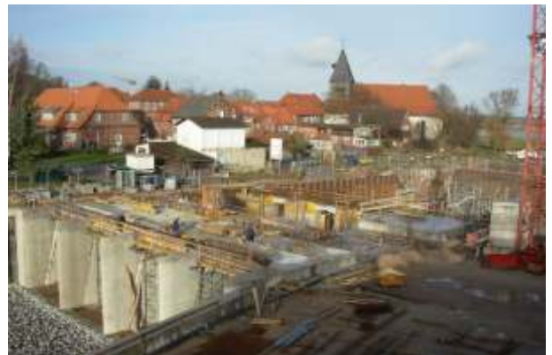
Schöpfwerksbau in Hitzacker
