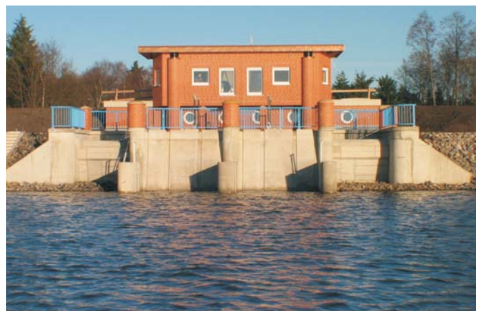
Das neue Auslaufbauwerk der Talsperre Thülsfeld
