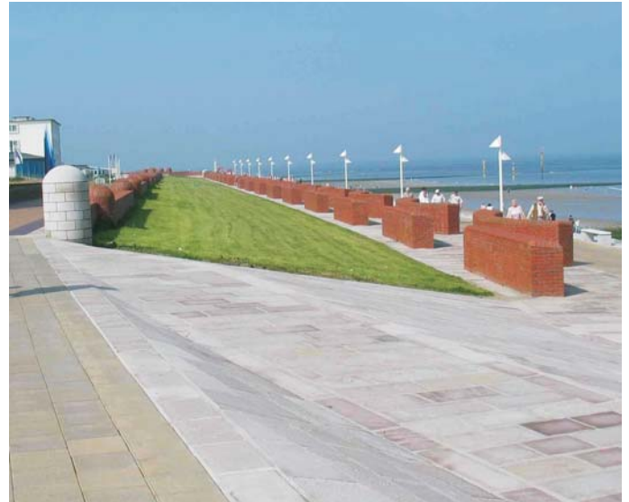
Sanierter Deckwerksabschnitt auf Norderney
