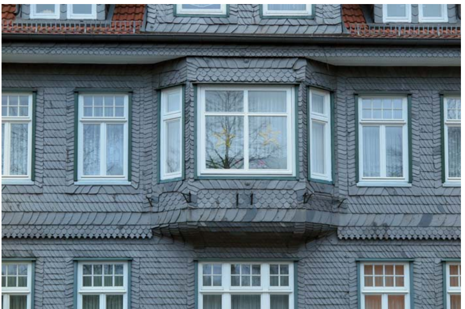
Mit Goslarer Schiefer aufwendig und detailreich verkleidetes Haus (Straßenansicht) in der Wallstraße / Goslar. Häuser mit vergleichbaren Wandbehängen und Dächern aus Schiefer prägen die Straßenzüge der Altstadt von Goslar am Harznordrand.
