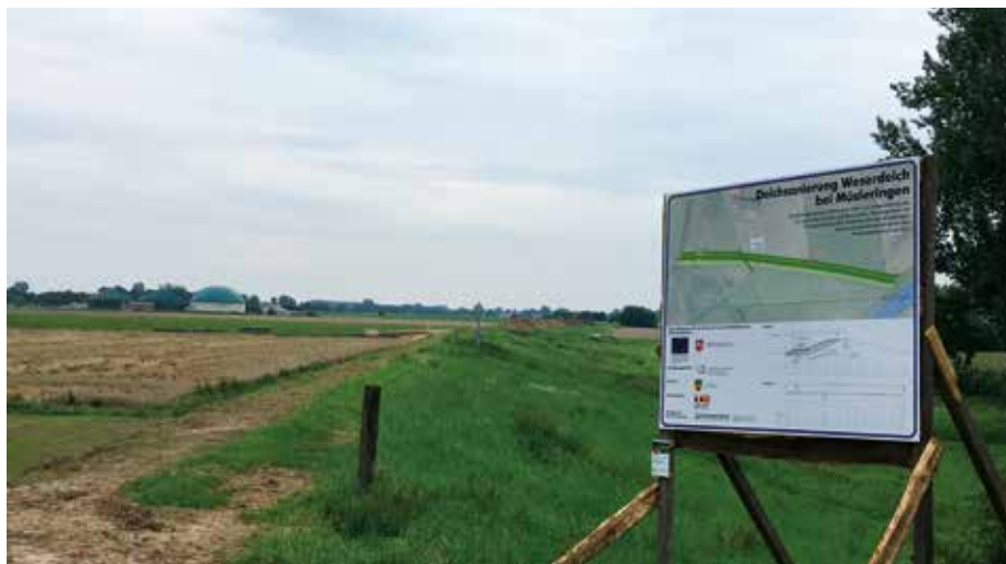
Auch vor Ort informiert der NLWKN mit großformatigen Schildern über seine Sanierungsvorhaben wie hier über die Verstärkung des Weserdeiches Müsleringen.
