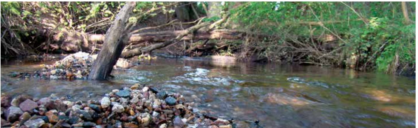
Kieseinbau wie hier am Eitzener Bach soll die Sohlstrukturen in Fließgewässern verbessern.
