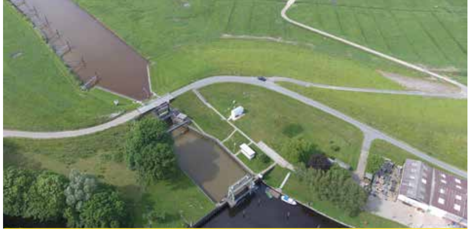
Derzeitiger Zustand: Die Hadelner Kanalschleuse ist zu niedrig und muss für kommende Herausforderungen angepasst werden.
