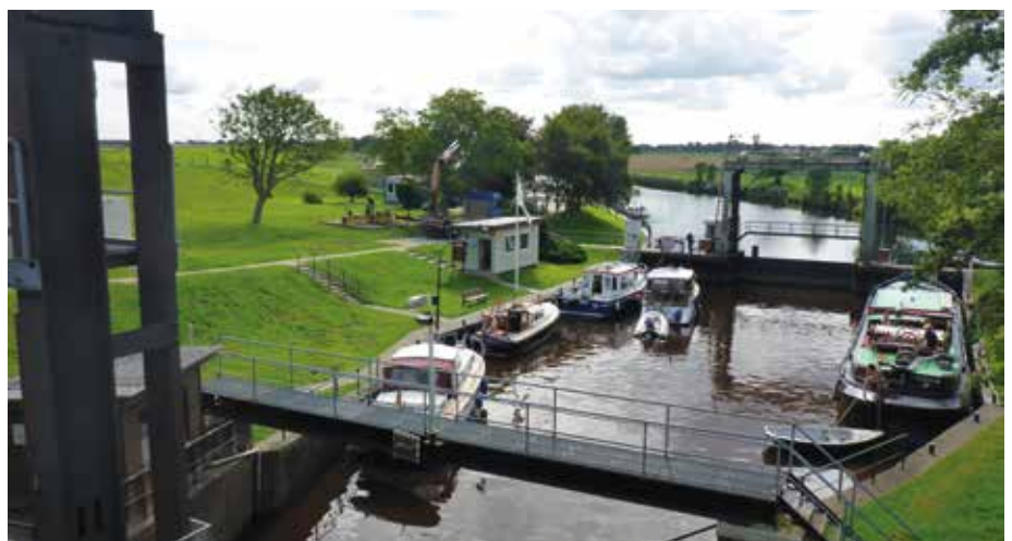
Die Hadelner Kanalschleuse ist 2018 noch für Boote nutzbar.
