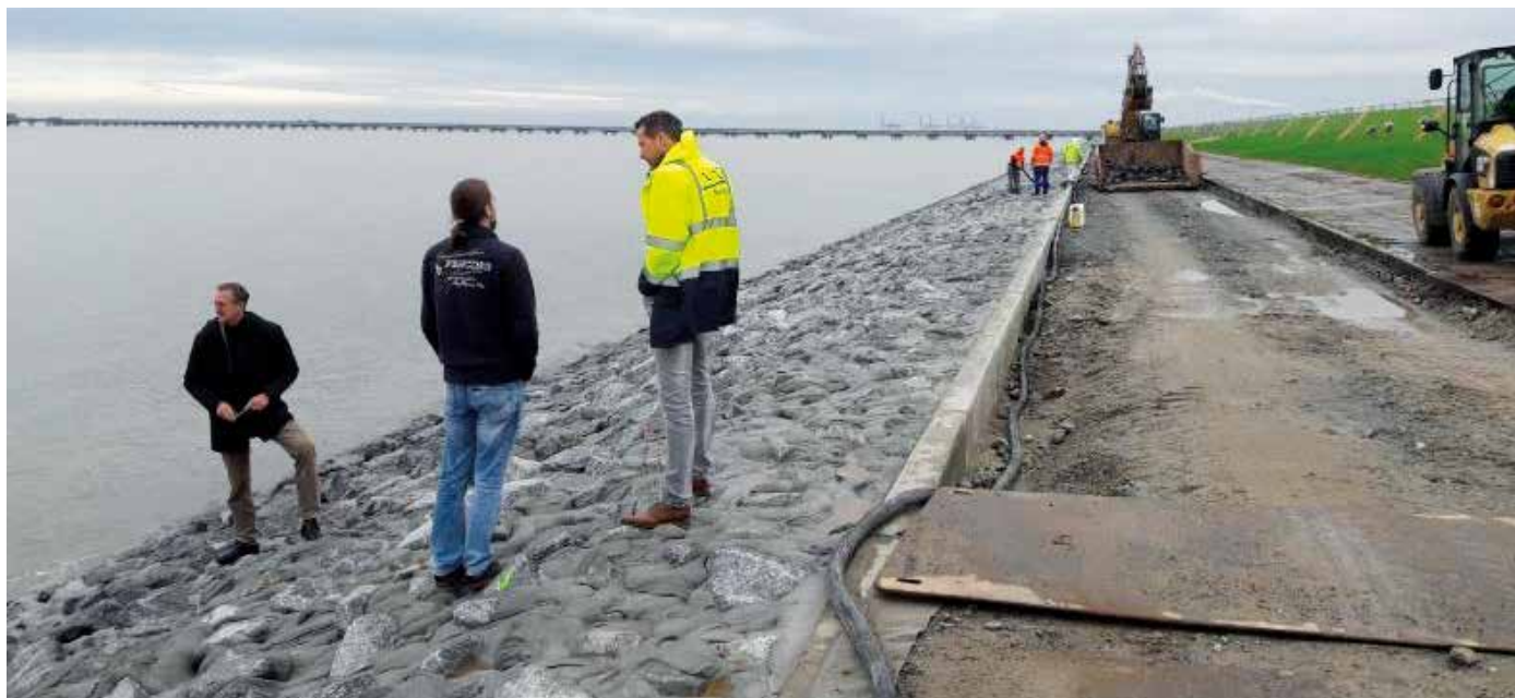
Am Voslapper Seedeich: Rainer Carstens, Johannes Leicht und Kai Wienken begutachten den Baufortschritt am Deckwerk.
