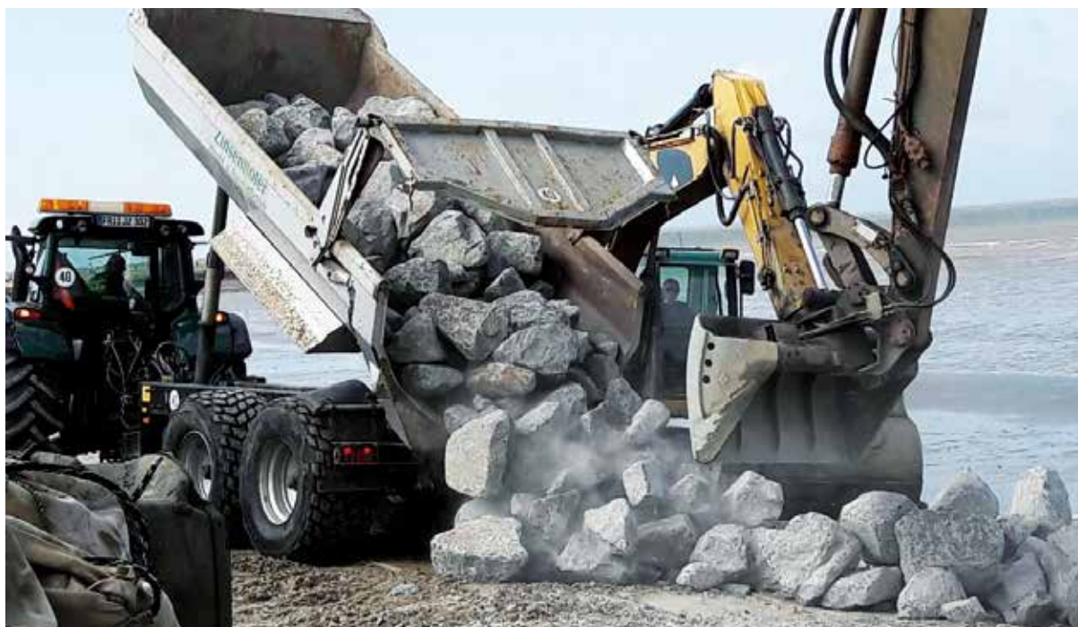
Schadens- behebung: Schüttstei- ne für das Deckwerk am Voslapper Seedeich.
