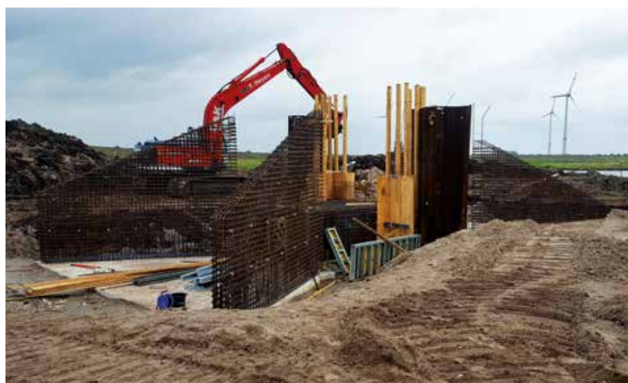
Der Hochwasserpolder Wittmund schützt die Ostfriesische Stadt zukünftig vor dem Wasser der Harle.
