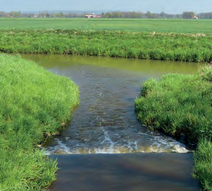
Durch den Umbau eines Abschnittes an der Elze (Landkreis Hildesheim) wurde die Durchgängigkeit des Gewässers für Fische wiederhergestellt.
