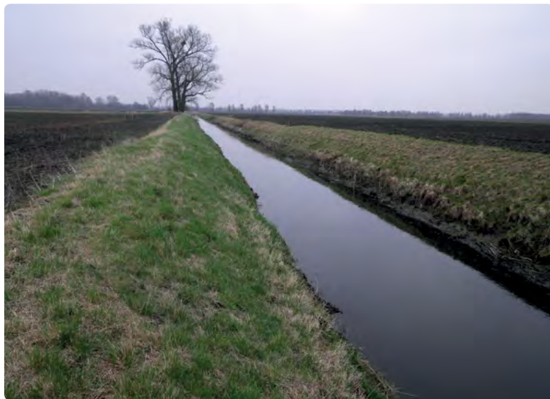
Fehlende Strukturen am Bruchbach (Landkreis Hildesheim): Viele Fließgewässer in Niedersachsen sind begradigt und ausgebaut.
