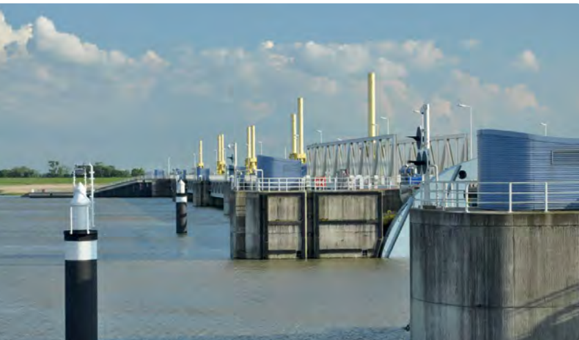
Eine geänderte Steuerung des Emssperrwerks soll helfen, dass weniger Schwebstoffe in die Unterems eingetragen werden.
