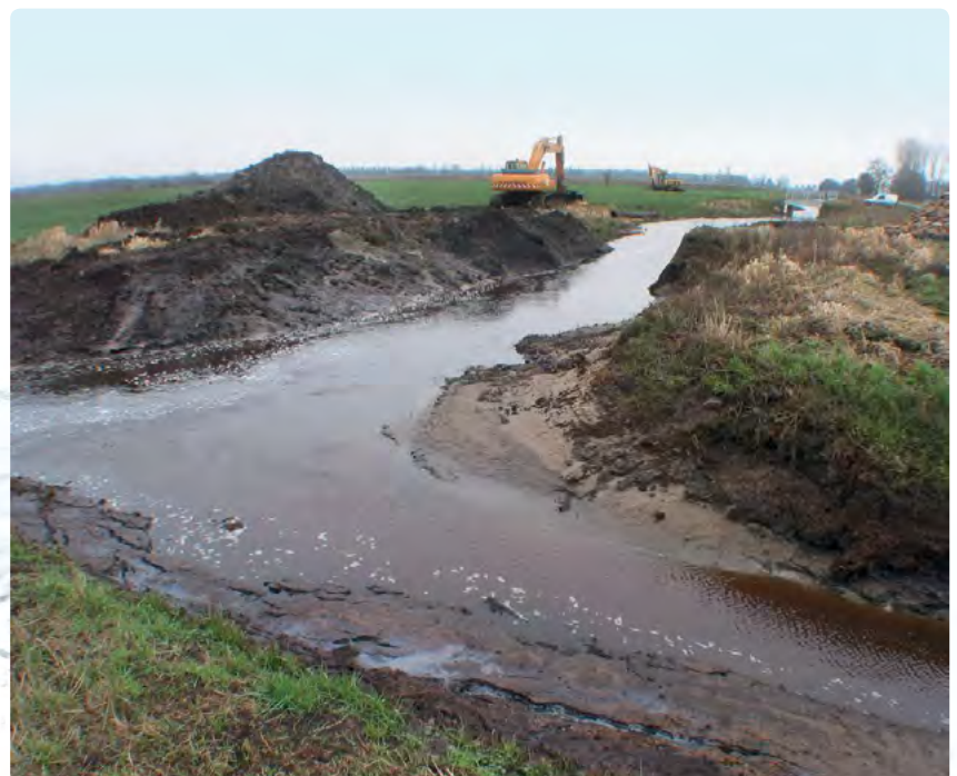
Herstellung der Bornbachumleitung zur Reduzierung der Nährstofffracht in den Dümmers (links Bornbach, rechts Altlauf Bornbach).
