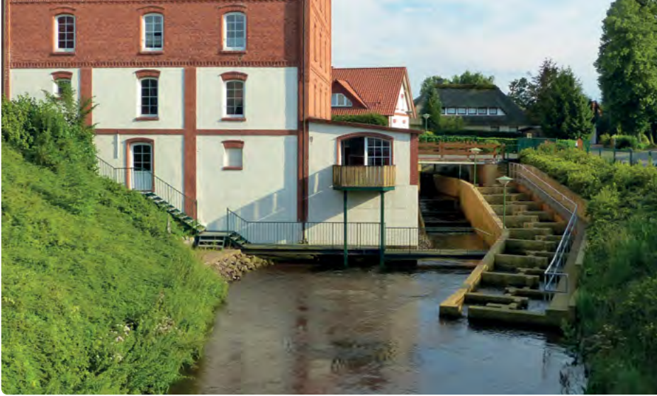
Eine Maßnahme auf dem Weg zum guten Zustand: der Bau von Fischtreppen an Wanderhindernissen, wie hier an der Großen Aue in Liebenau (Landkreis Nienburg/Weser).
