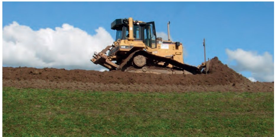
Der Elbedeich vor Barförde im Landkreis Lüneburg wird nach dem Elbehochwasser 2013 erhöht und verstärkt.
