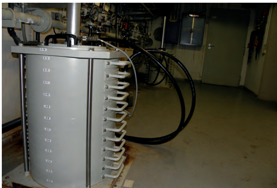
Kernkraftwerk Unterweser: Die Messgefäße der Radioaktivitäts-Messstellen „Nebenkühlwasser“.
