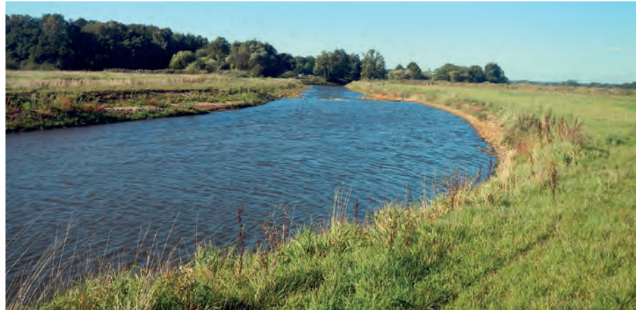
Wümme naturnah: Umwandlung der Schleuse V bei Hellwege in eine Sohlgleite.
