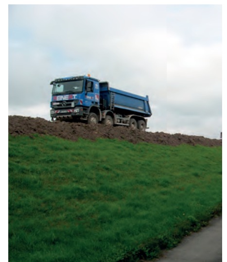
Der Elbedeich vor Sassendorf im Landkreis Lüneburg erhält eine dicke Kleischicht.
