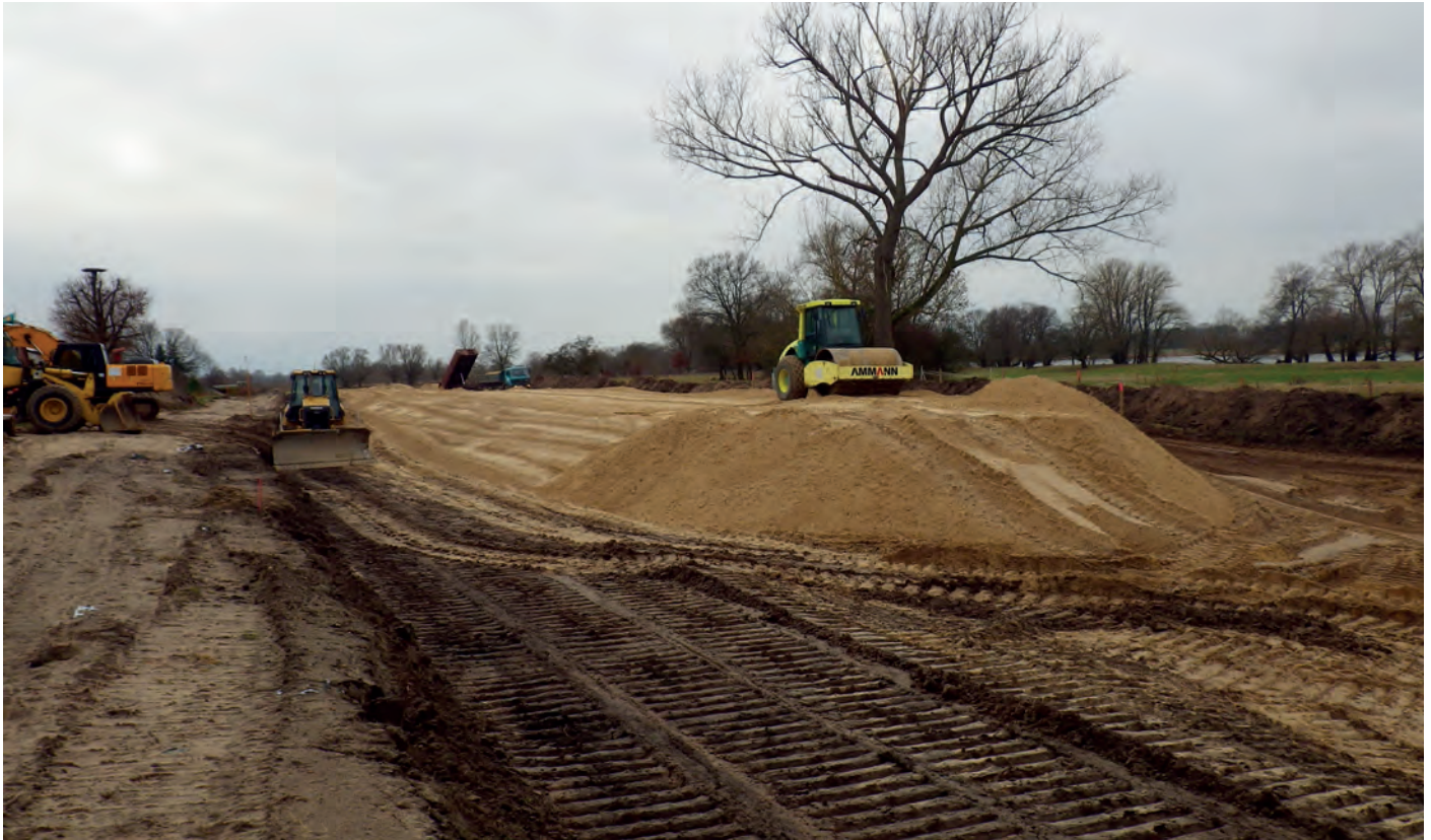
Aufatmen in Vietze im Landkreis Lüchow-Dannenberg: Ein neuer Deich schützt vor dem Hochwasser der Elbe.
