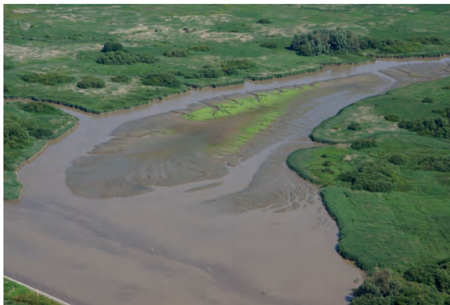
Ems-Altarm bei Vellage: Der Einlaufbereich für den geplanten Pilotpolder.
