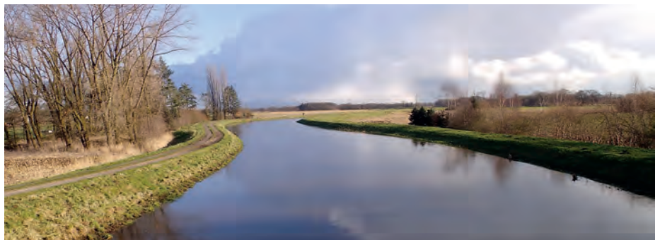
Verden 2016 verstärkt: Die Dämme an der Gehobenen Hase.
